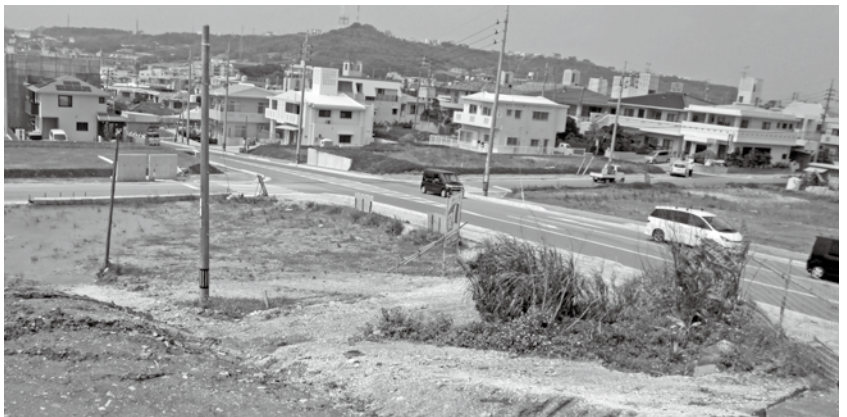
津嘉山中央線街路区域は徐々に整備されているが、未整備で危険な交差点も多い。
