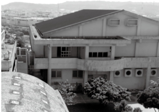
北丘小学校の体育館
